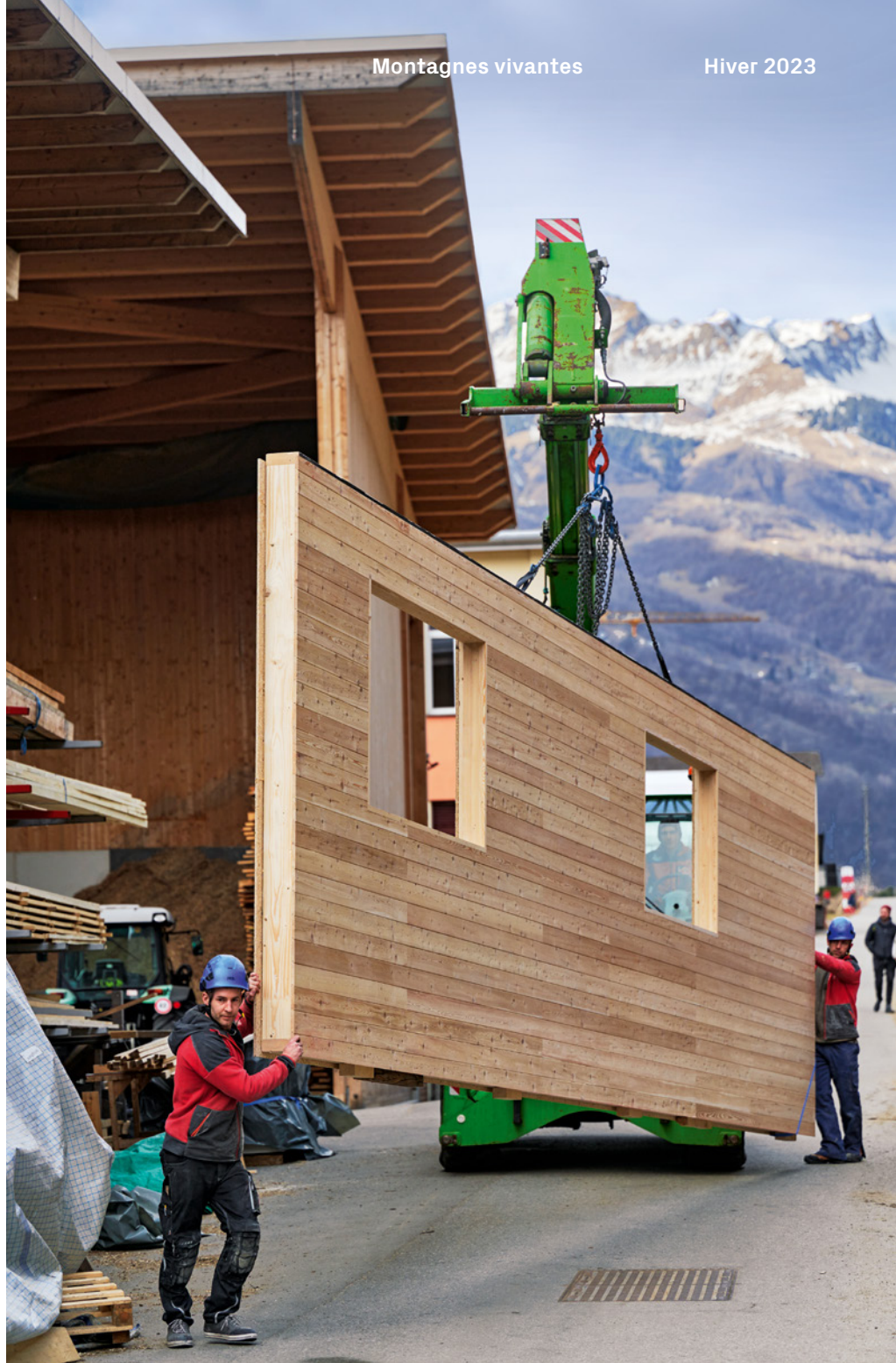
Le déplacement pénible des éléments de construction par manque de place appartiendra bientôt au passé.
